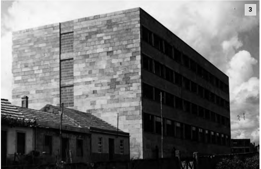
1, 2, 3. Distintas fases do proceso de construción do novo Instituto de Ensino Medio, anos 1966-67. Fondo fotográfico do Museo do Pobo Estradense Manuel Reimóndez Portela.
