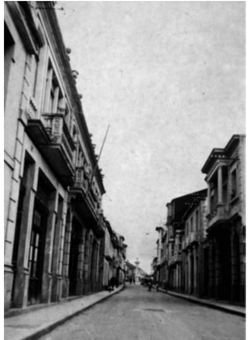
Sede del Instituto en los años 30. Con el paso del tiempo albergaría en tres de sus aulas la antigua Biblioteca Municipal.
